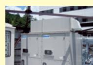
高効率型水冷チラー(冷房能力 80RT×2台)
