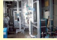
冷凍機排熱回収装置(予熱槽容量 3.0m<sup>3</sup>×1台)
