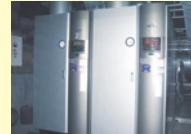
高効率蒸気ボイラ(換算蒸発量 1.5ton/h×2台)
