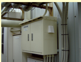
冷凍機冷媒ガス圧力制御
