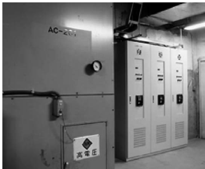
ファンへのインバータ設置
